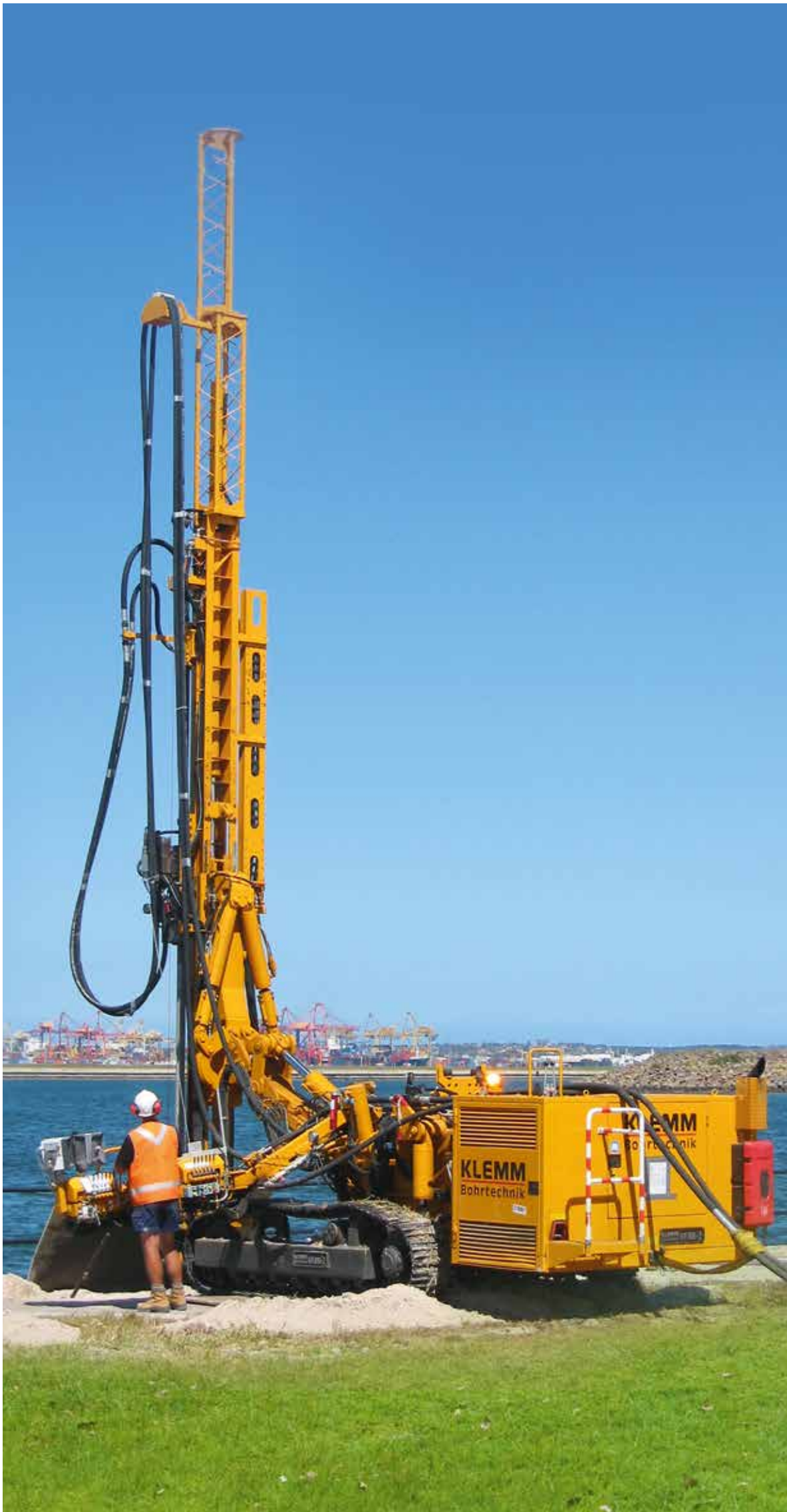
Hochdruckinjektionen High-pressure injections
